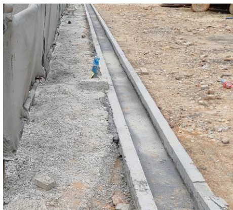
砂浆抹面排水沟
