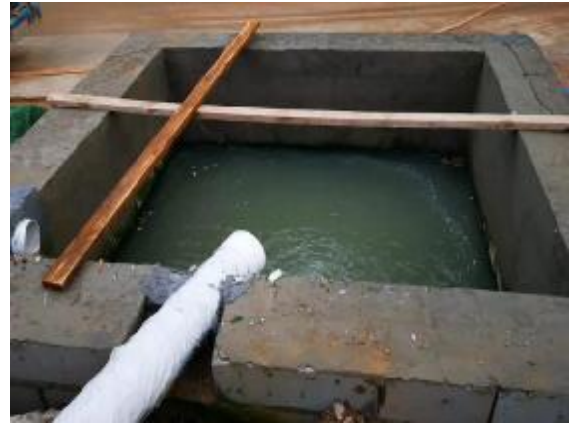
集水井（2019年6月）已拆除
