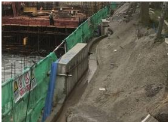
水土保持临时措施2019年6月（断面尺寸30×30）（已拆除）
