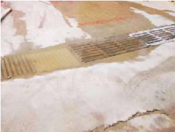
临时排水沟（2019年6月）已拆除
