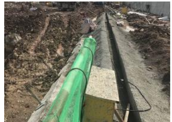
水土保持临时措施2019年6月（断面尺寸30×30）（已拆除）
