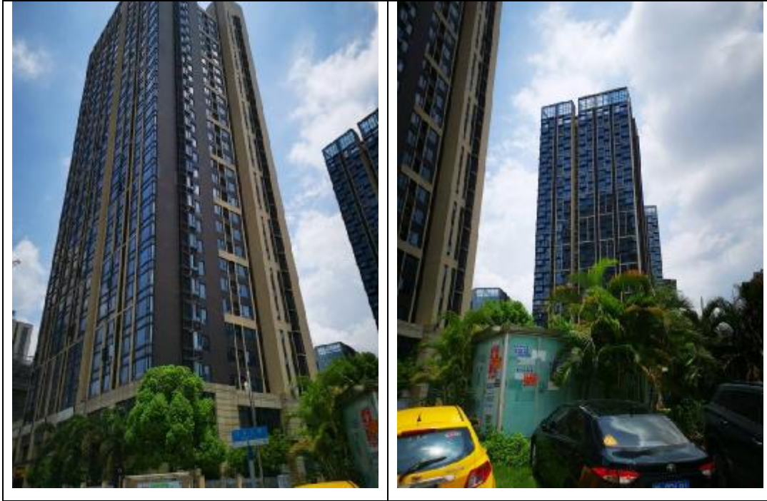
图1.1-1 部分建筑物现状图
