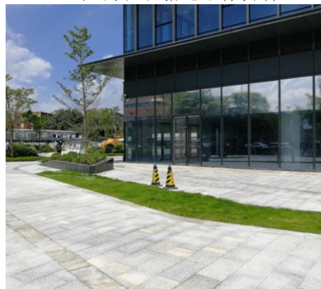
植物措施现状2
