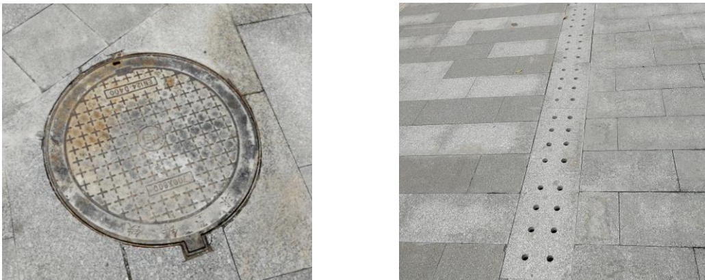
图3.5-1 水土保持工程措施现状图
