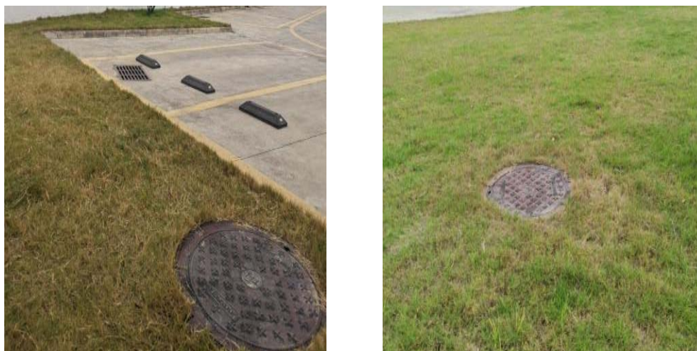
图4.1-1 水土保持工程措施现状
