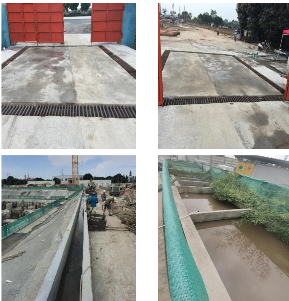
图4.3-1 水土保持临时措施
