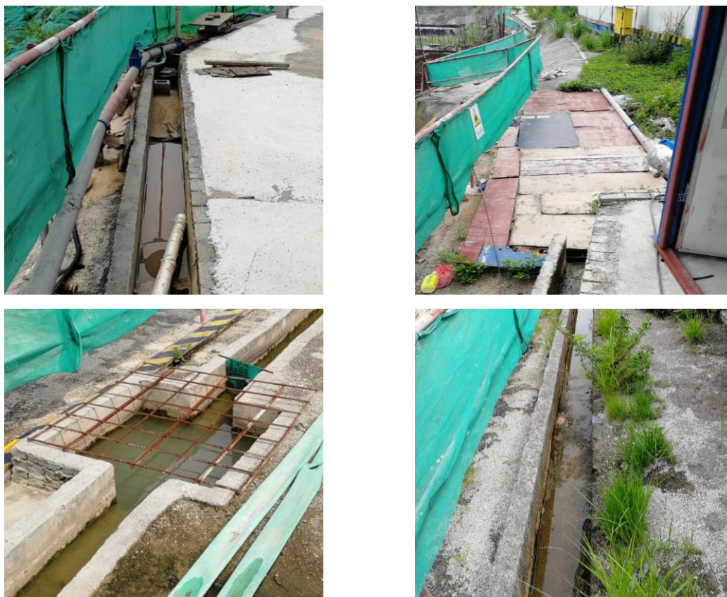
图4.3-1 水土保持临时措施
