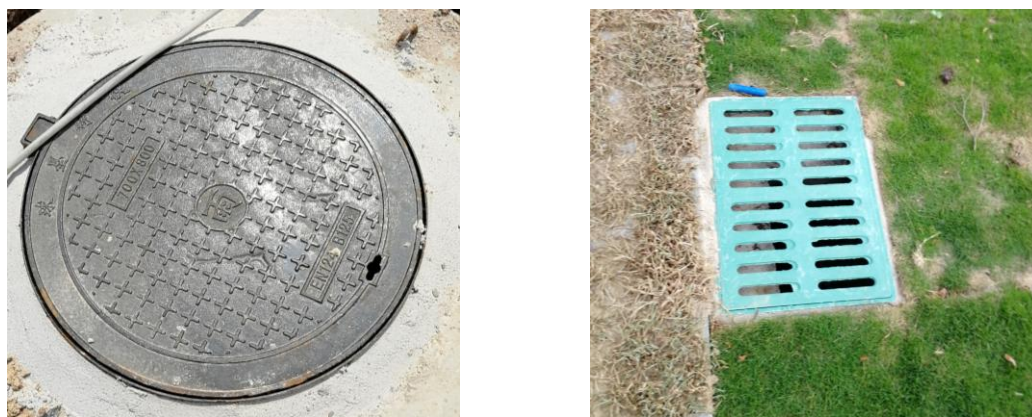
图4.1-1 水土保持工程措施现状
