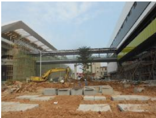
2018.10 代征绿地区绿化施工
