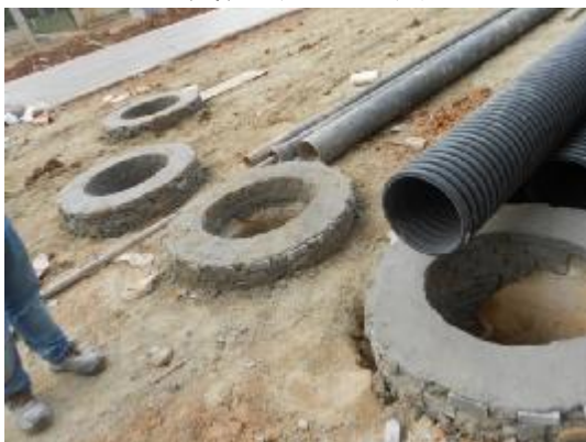
2018.10 区内管线施工
