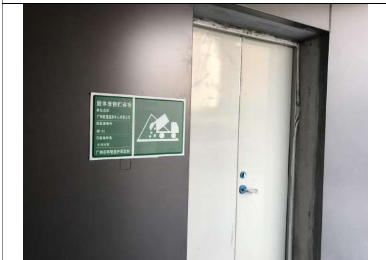
生活垃圾收集房：固-01（远照）
