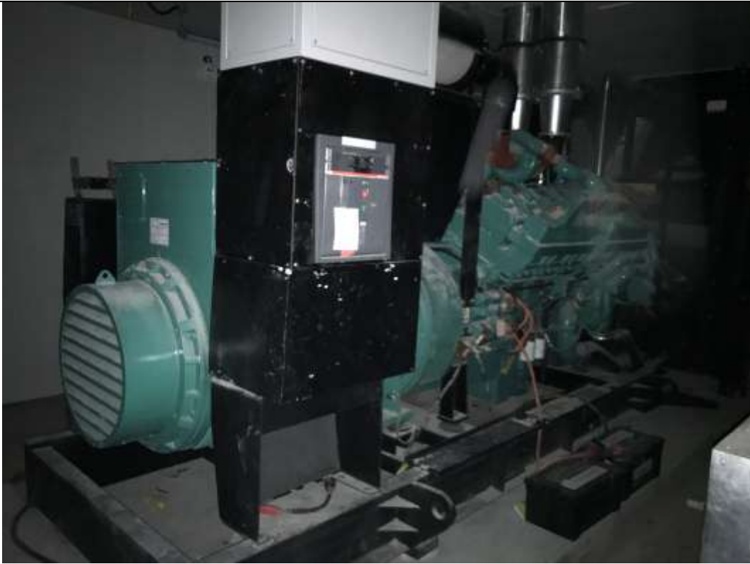
发电机及减振、隔声墙
