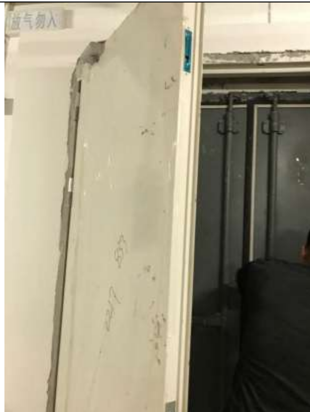
1号发电机隔声门
