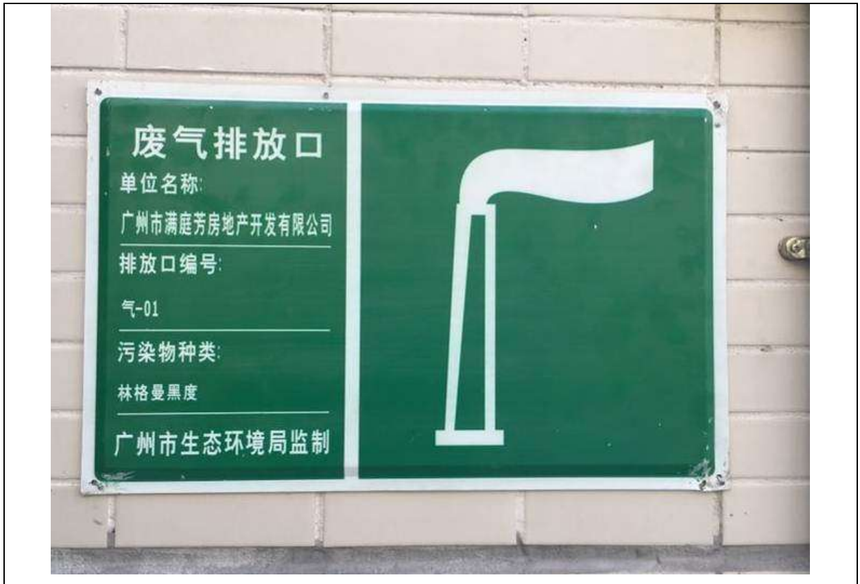
发电机尾气排放口：气-01（近照）
