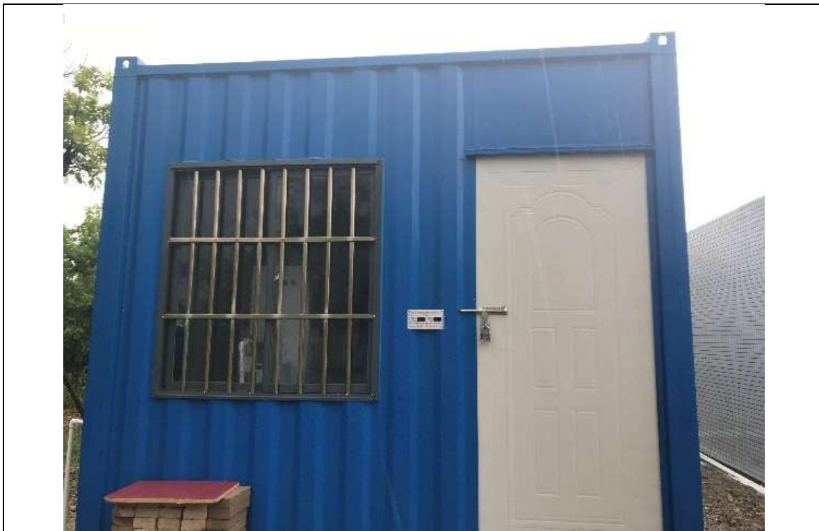
在线监测系统设备房外观
