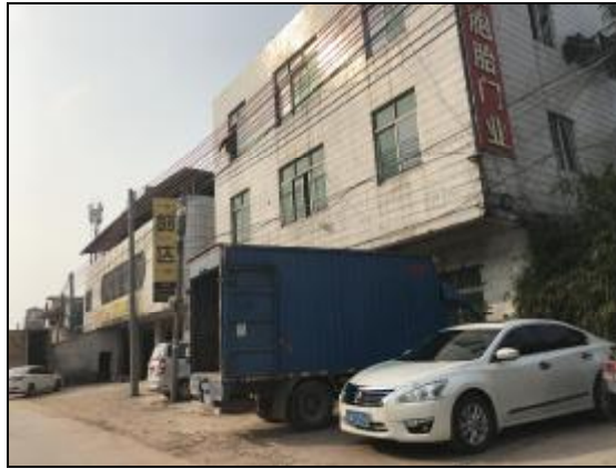
西北面：工业厂房
