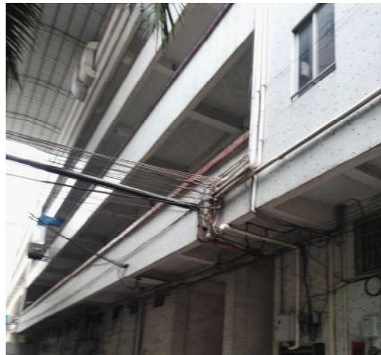
项目北面：唐阁工业广场工业厂房
