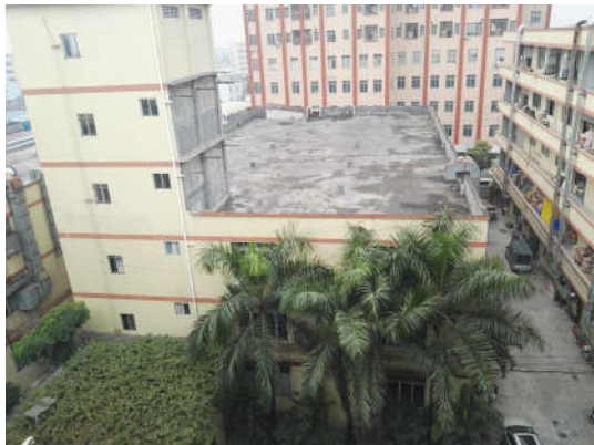
项目西面：工业厂房
