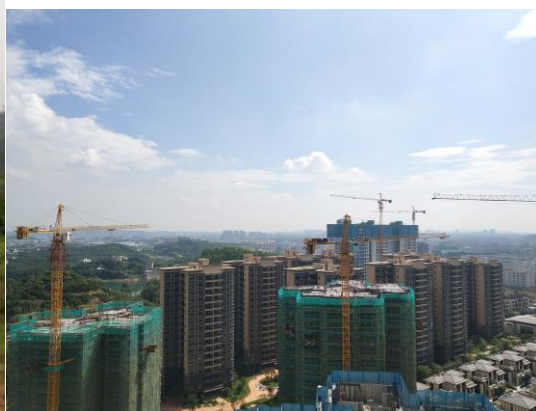
东北面: 施工工地
