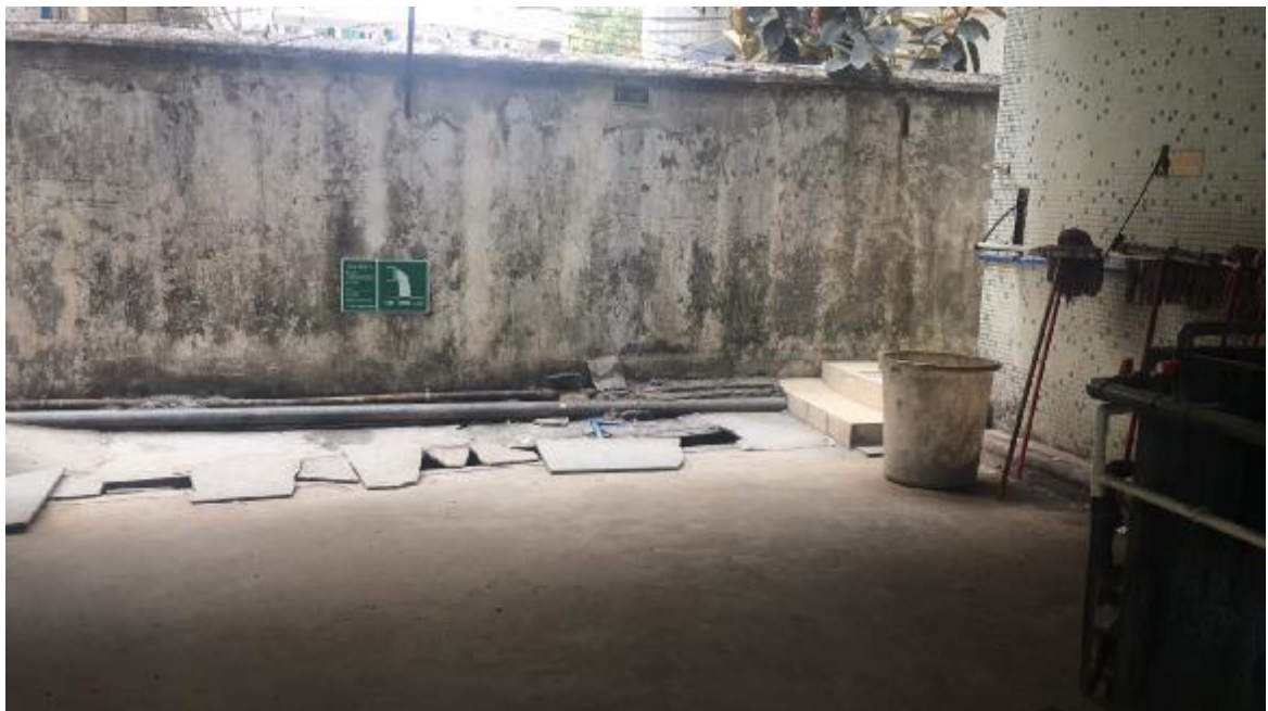
水-01 废水排放口
