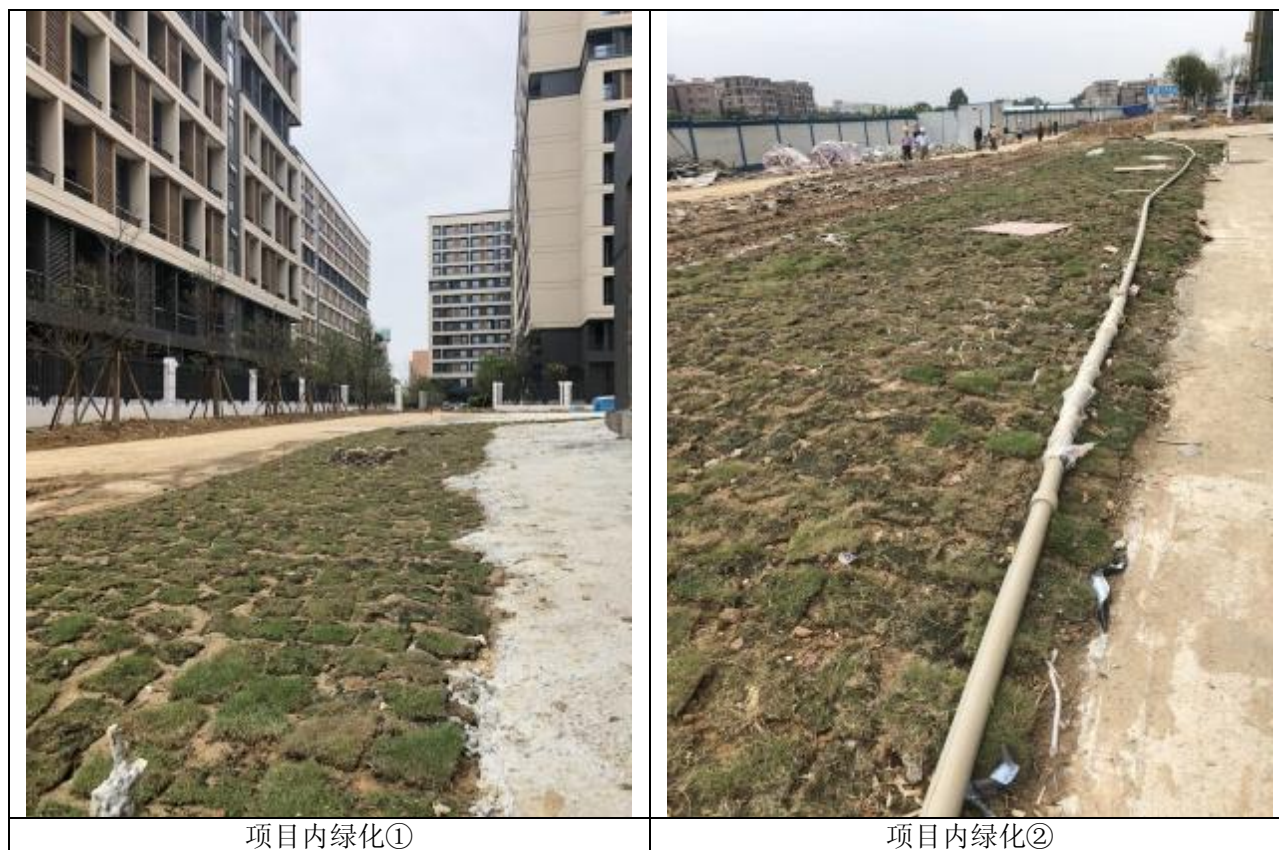
图 3.3-3 建设项目及周边情况照片
